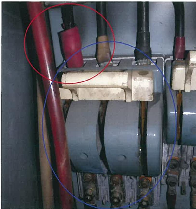
交換後 （ブレーカの露出部分には塩ビ板を加工し充電部保護カバーも取付ました。）
